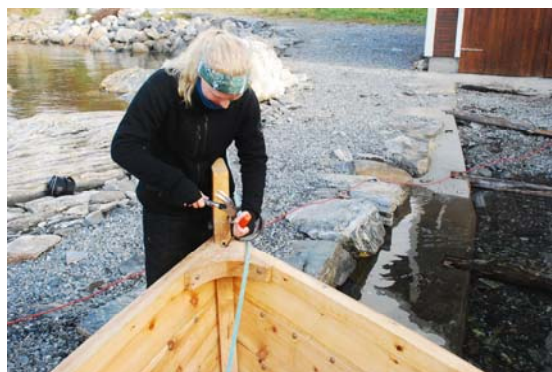
Kine Sagnes og Asgeir Domaas Pedersen gjør klart for bolt gjennom stammen for innspleising av urve som feste for stag.
