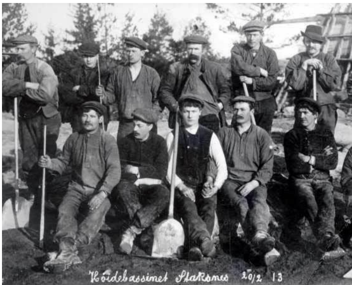
Anleggsarbeidere på Staksnes (senere Eydehavn) i 1913, fotografi Aust-Agder kulturhistoriske senter
