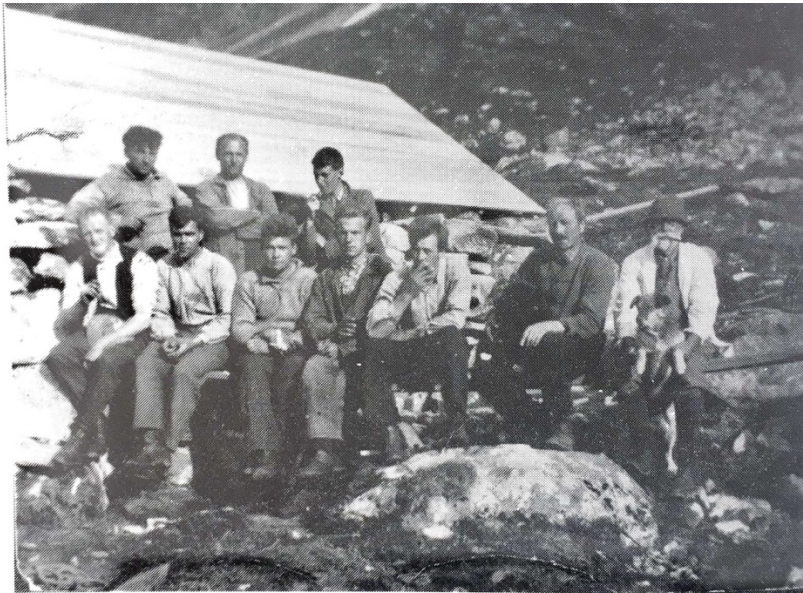
Dugnadfolk ved bygginga av Patchell-hytta. Fyrste rekkje frå v.: Karl Leite (portier på Union), Bernt O. Urke, Bernhard Øye, Knut Skylstad, Paul Urke, Lars Norangshol med Bob og C. W. Patchell med Jeff. Andre rekkje frå v.: Johan B. Øye, mr. Mcdonald og mr. Maitland.
